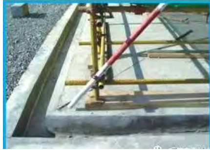
■脚手架基础排水沟图
